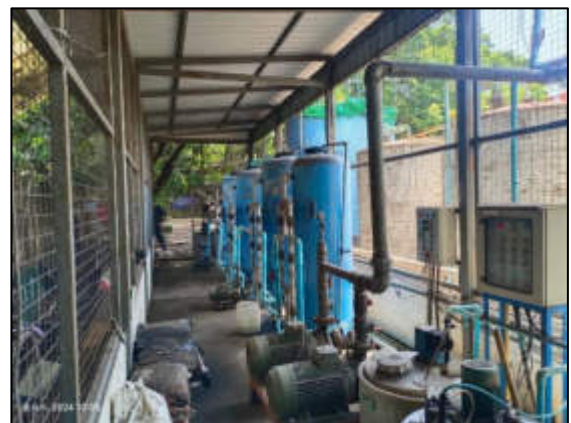
รูปที่ 16 ระบบปรับปรุงคุณภาพน้ำใต้ดิน
